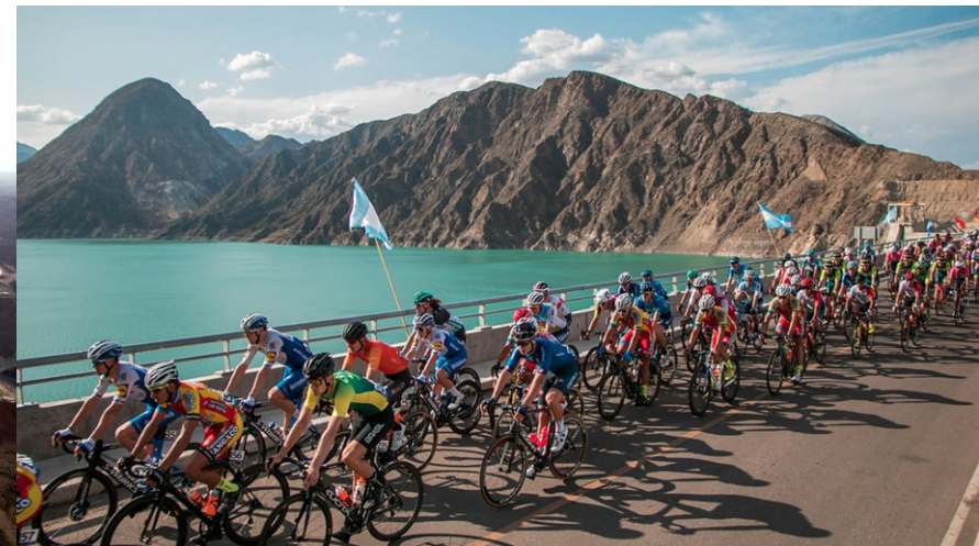
DIQUE PUNTA NEGRA
